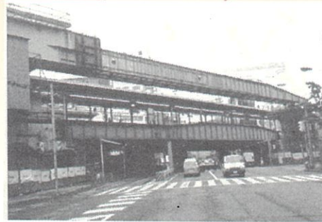
平成2年(1990) 神田駅東口付近での新幹線用橋桁工事の様子。これにより昭和31年(1956)に開設された列車線(留置線)は解体され、新しい橋脚は、上部に継ぎ足せる構造で建設された。(資料32)
