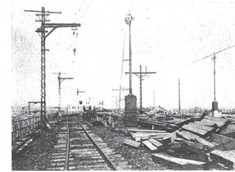
東京駅方面からの神田駅、西口アーチ上部。(資料15)
