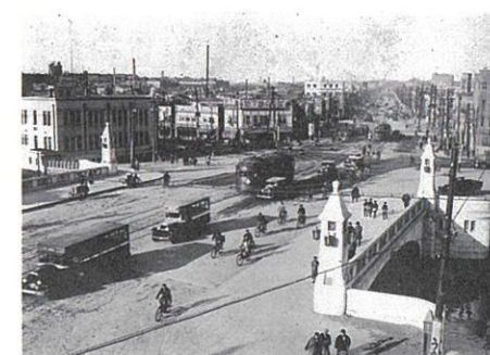
昭和5年(1930)9月、完成した万世橋。橋は地下鉄と一体でつられている。写真中央に「地下鉄のりば」(万世橋駅)の案内が見える。(資料20)
