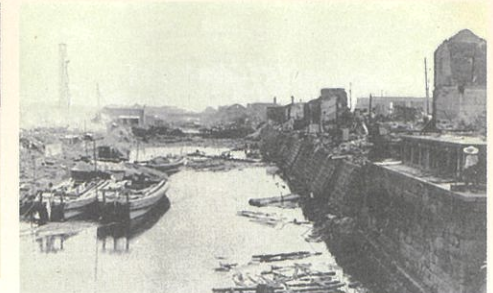
震災の5日後、万世橋から和泉橋方面を望む。右側奥に震災前に完成していた高架橋。(資料13)
