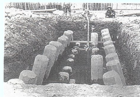
基礎コンクリート杭の打ち立てが終了。(資料7)
