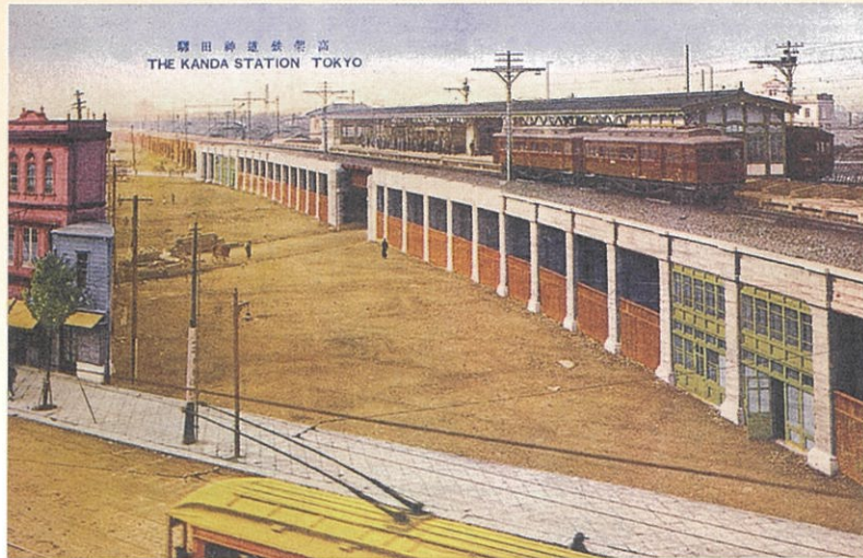
神田駅開設頃の姿。空地は、東京・上野間の高架線の建設予定地として、すでに杭打工事等が終了している。この辺は地盤が悪く、アーチ橋ではなく鉄筋コンクリートスラブ橋で建設されている。(資料4)
