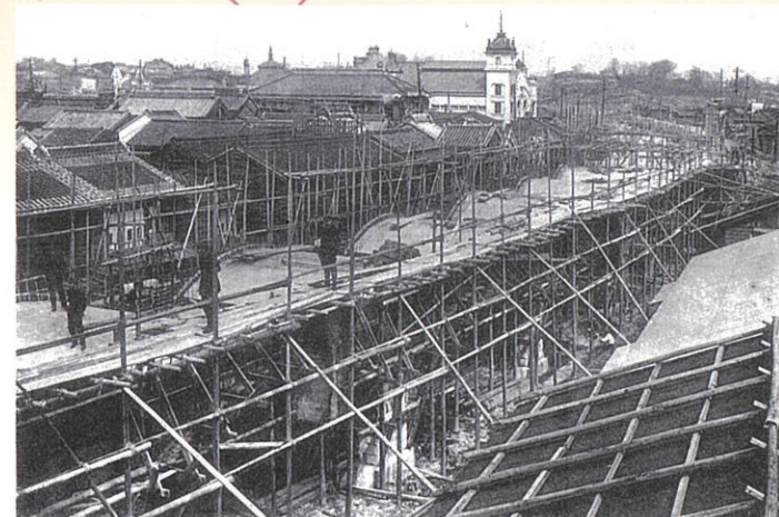
「第二小柳町橋」付近(現・靖国通り)から万世橋駅方面をみた工事写真。(資料7)
