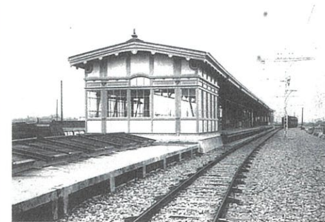
東京駅方面からみたホーム、左に構内明り取りの天窓がある。(資料7)
