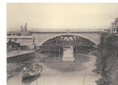
万世橋から見た神田川橋、鉄筋コンクリートアーチ橋で外濠橋に比べ簡素なデザインとなっている。(資料5)
