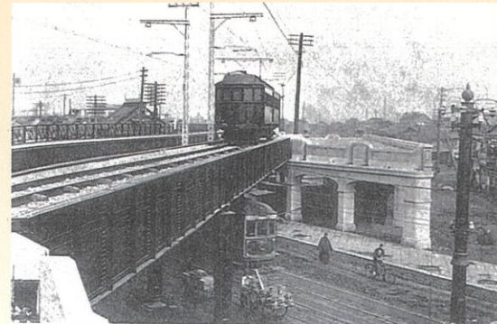
手前の架道橋は、神田大通りに架かる大通橋。奥の高架橋は第三鍛冶町橋。ここに、料理店「今金」があつた。(資料7)
