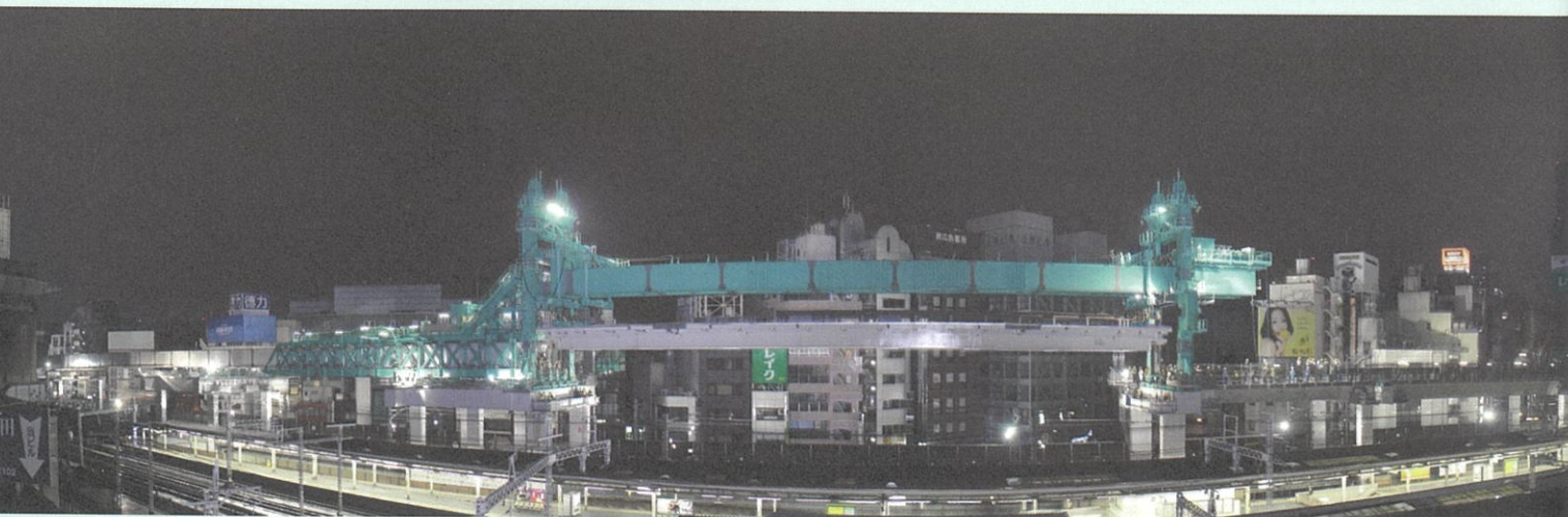
新幹線の上に高架橋の桁を縦断的に設置するための「桁架設機(けたかせつき)」全長210m、重さ1700トンの巨大な機械が使用された。写真は平成24年(2012)3月、最大の橋桁となった神田大通り上で57mの鋼桁を設置している様子。この他にも、43mの鋼桁、20~39mのPCコンクリート桁17本を架設するために使用された。(資料33)
