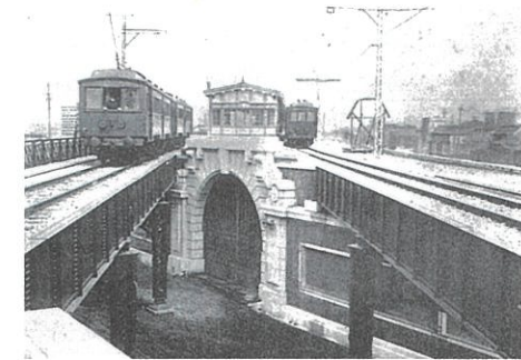
神田駅西口。入口を飾った石組や赤煉瓦は現在取られ、パネルなどに代わってしまった。(資料7)
