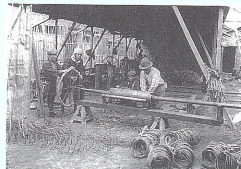
建設用地内でコンクリート杭用の鉄筋材を加工している。(資料7)
