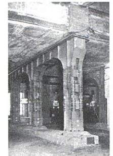
壁式橋脚を撤去し、柱状の鉄骨橋脚に。交通の自由度は増したが、道路と段差が生じた。(資料23)
