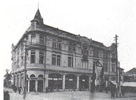
明治40年(1907)11月に竣工した今川橋松屋。道路拡幅に合わせ、木骨石皮構造による百貨店の原型のような店舗となった。(資料2)
